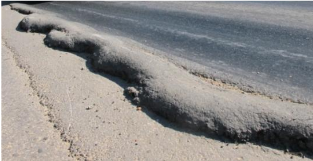
Lớp nhựa "vá" chảy tràn ra hai bên đường
