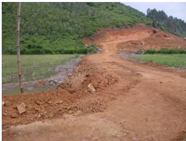
"Bất thường" tại dự án nâng cấp đường vào hồ chứa nước Xuân Hoa
