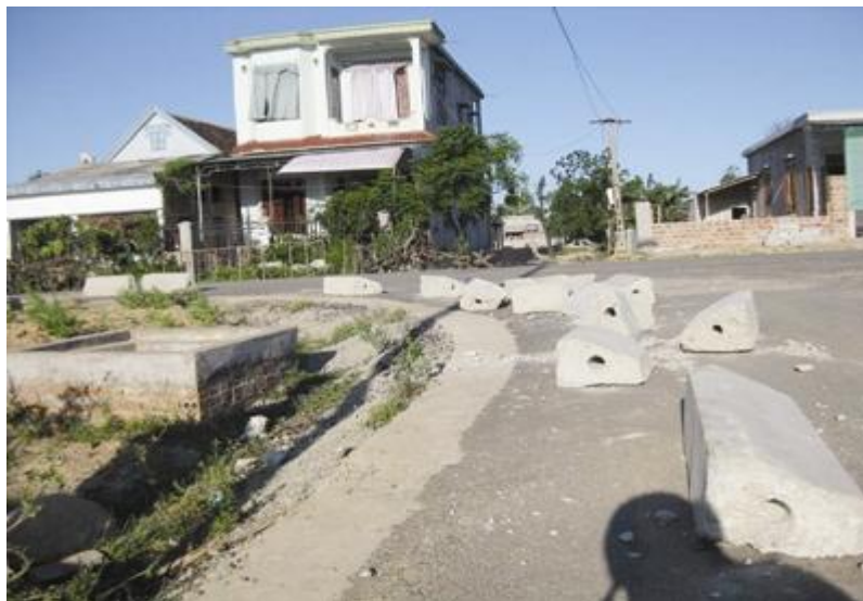
Khu tái định cư nhếch nhác vì thi công ẩu.
