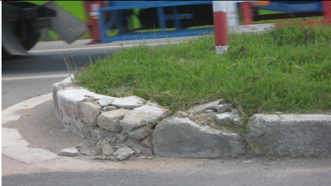
Phần cuối dải phân cách cũng bị hư hỏng
